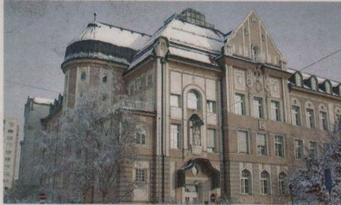
Die Kornerschule in Linz ist nur eines von vielen Projekten, die von den Dichtungsprofis durchgeführt wurden.
